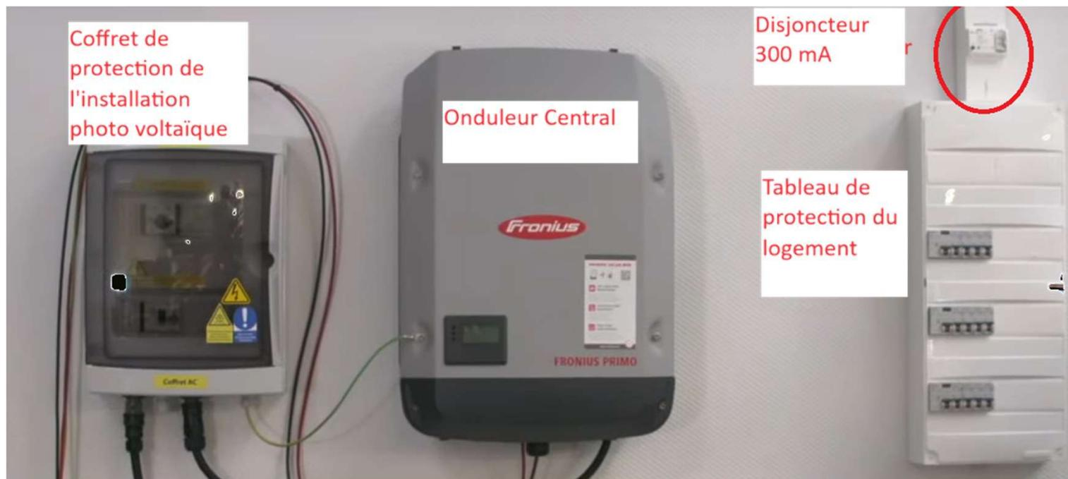
Exemple de montage d'un tableau de protection d'une installation avec un onduleur central
